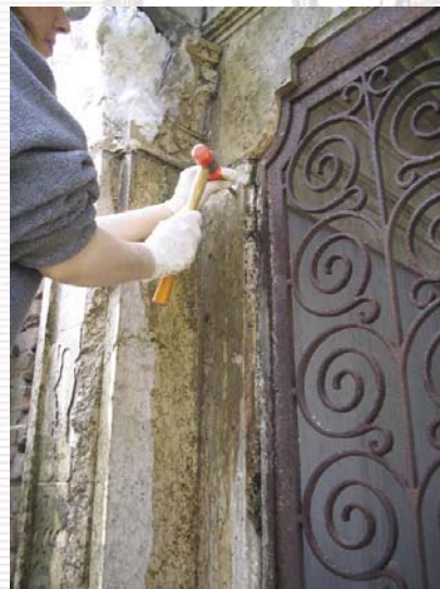
Smontaggio della porta metallica.
