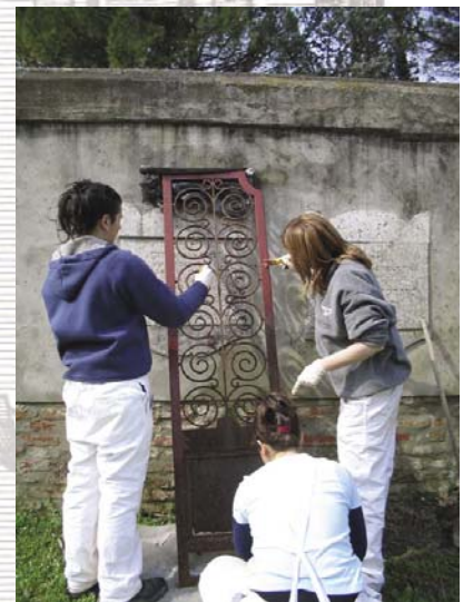
Applicazione di convertitore antiruggine.
