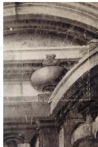
Tassello di pulitura e operazioni di descialbo.
