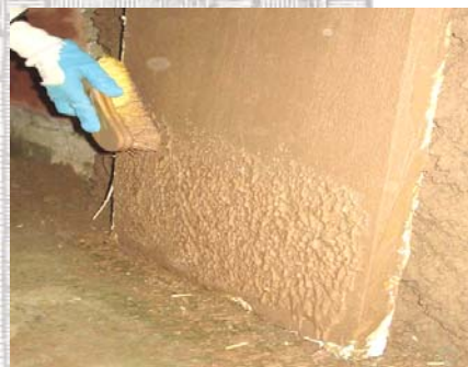
Bagnatura del muro e stesura dell'intonaco.
