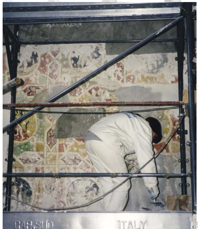
Particolare del ponteggio di servizio utilizzato per eseguire le operazioni di restauro.
