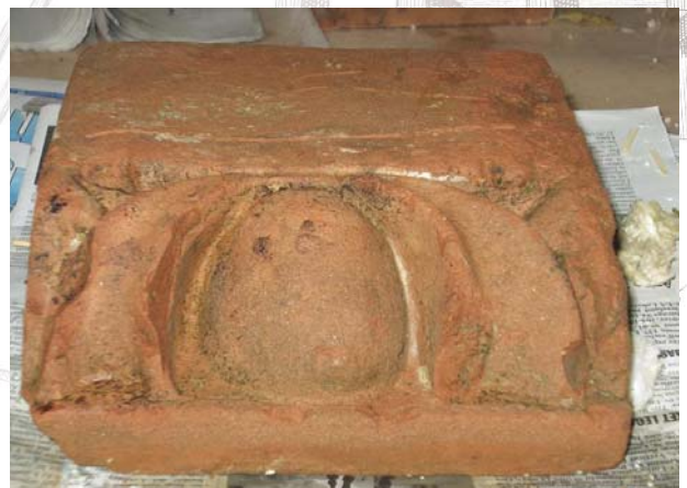
Elemento in cotto dopo l'intervento di restauro.
